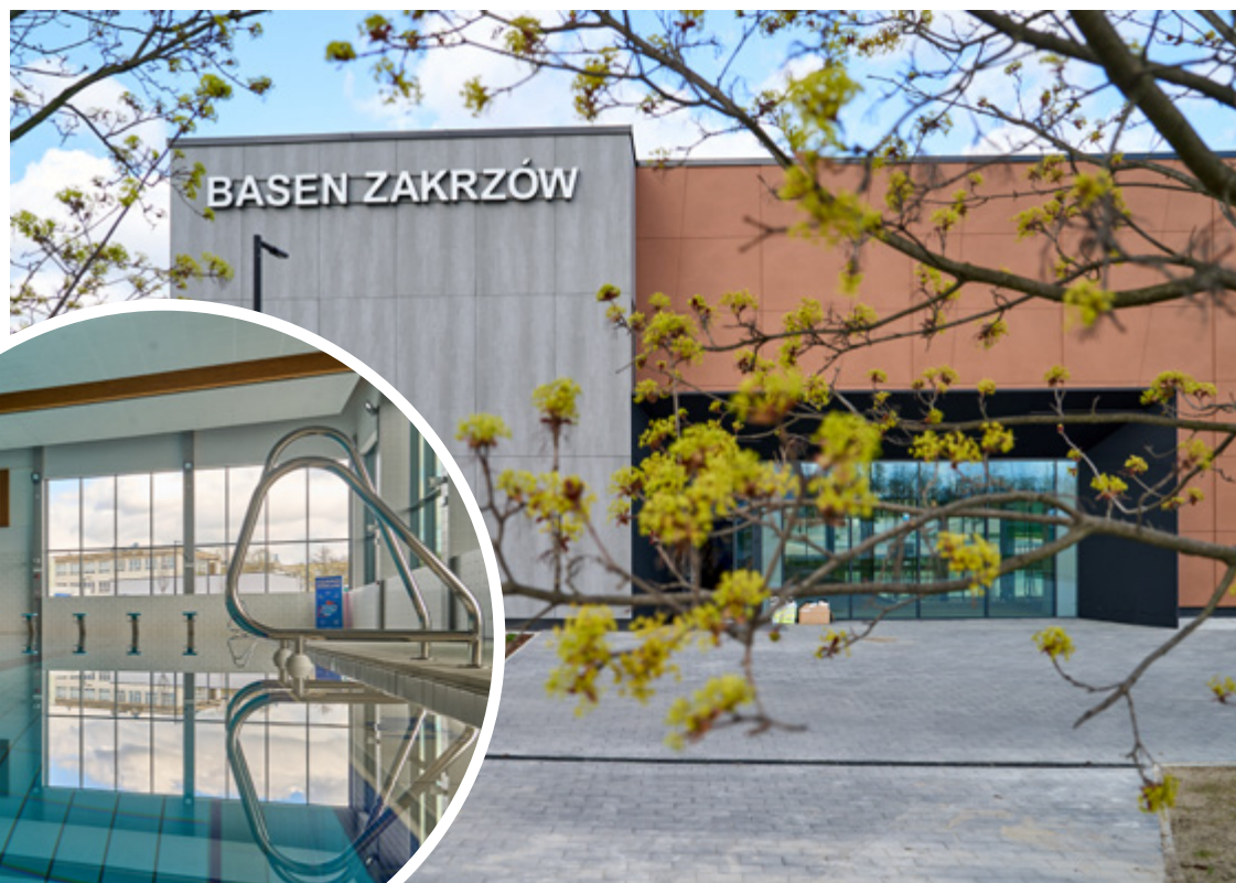
Budowa jest zakończona, do basenów napełniono wodę
